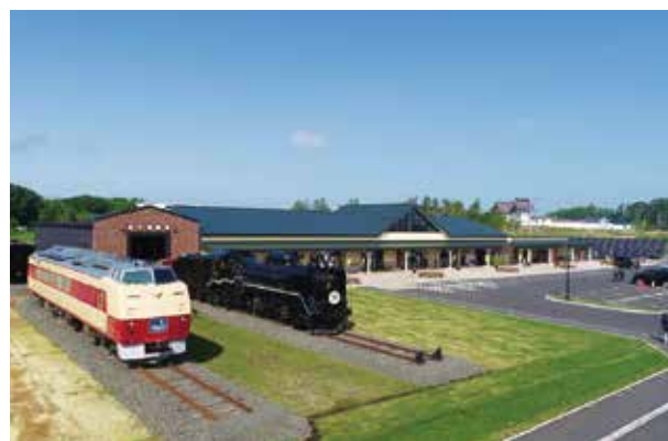
道の駅「あびらD51ステーション」
