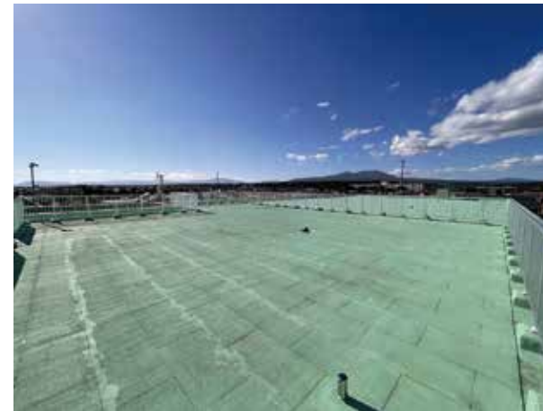
屋上に設けた一時避難スペース
